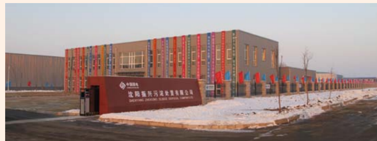
© 沈阳市污水处理厂污泥处理工程顺利竣工投产
